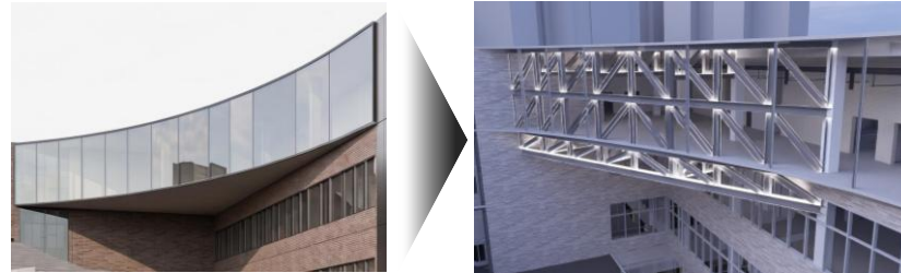
전망대 14m 캔틸레버 구현위한 메가트러스 설치 및 곡률수정
