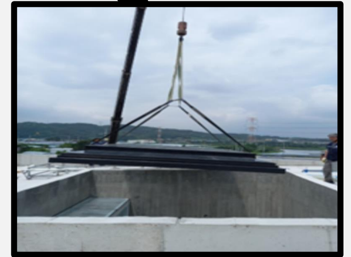
지정된 위치에 유리 창 설치
