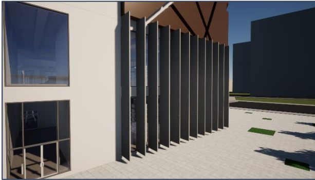
동측 입면 수직 루버 BIPV
